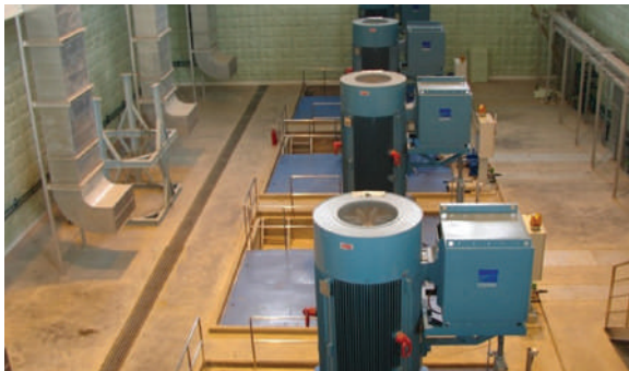
สถานีสูบน้ำคลองขุดวัดช่องลม
