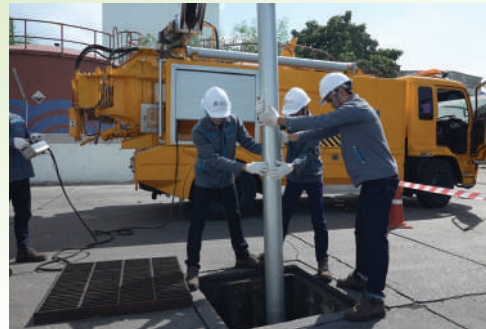
การตรวจสอบระบบท่อรวบรวม และกำจัดขยะภายในบ่อ
