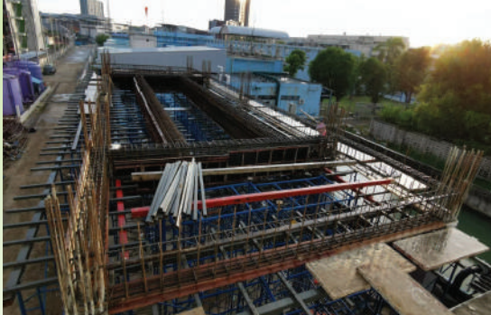
งานก่อสร้างอาคารระบบกำจัดตะกอน
