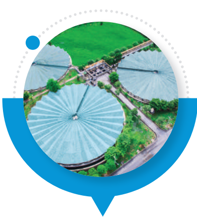
ระบบบำบัดน้ำเสีย
