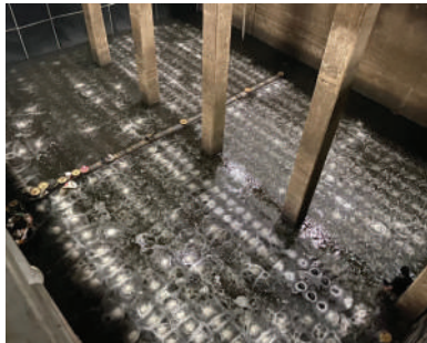
ถังเลี้ยงตะกอน และถังเติมอากาศ
