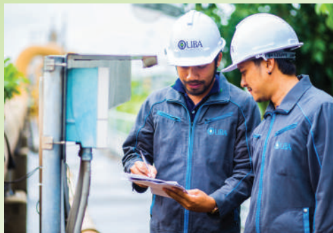
การตรวจสอบและบันทึกค่าการทำงานของเครื่องจักรอุปกรณ์
