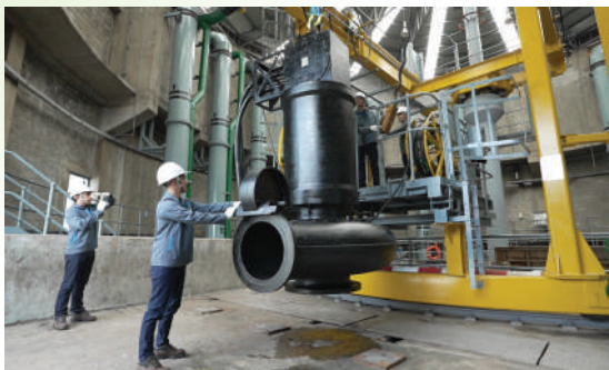
งานจัดหาและติดตั้งเครื่องสูบน้ำเสีย
