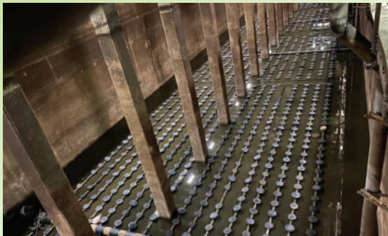
งานจัดหาและติดตั้งห้วงจ่ายระบบอากาศ ในบ่อเติมอากาศ
