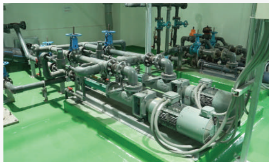
งานจัดหาและติดตั้งเครื่องสูบน้ำตะกอน
